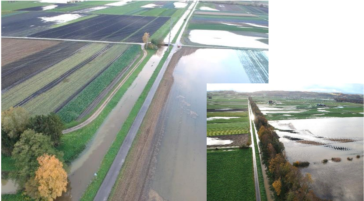
Abb. 1: Aufnahmen Hochwasser Nov. 2023 im Grossen Moos
